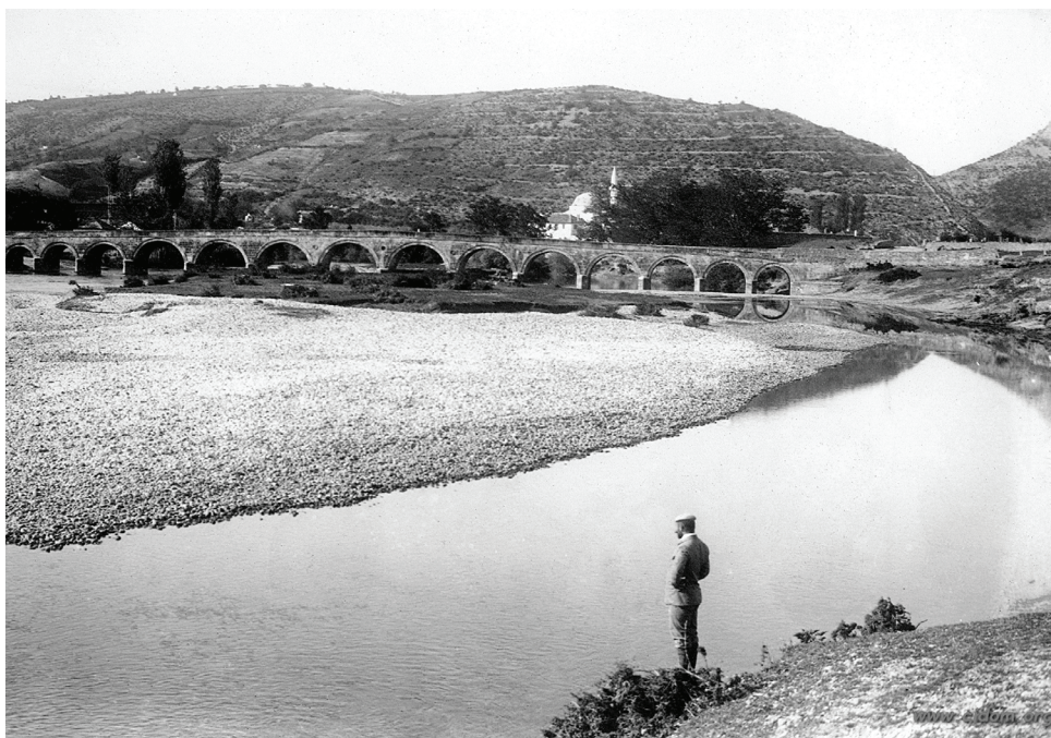
Stara fotografija Danijal – pašinog mosta
